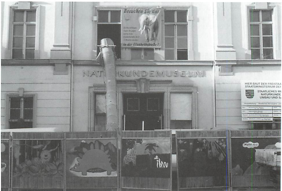
Eingang des Naturkundemuseums als Baustelle
