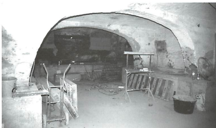
Der alte Kohlen- und Heizungskeller vor der Bodenabsenkung
