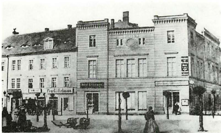
Das Museumsgebäude der Naturforschenden Gesellschaft zu Görlitz in seiner ursprünglichen Gestalt ab 1860
